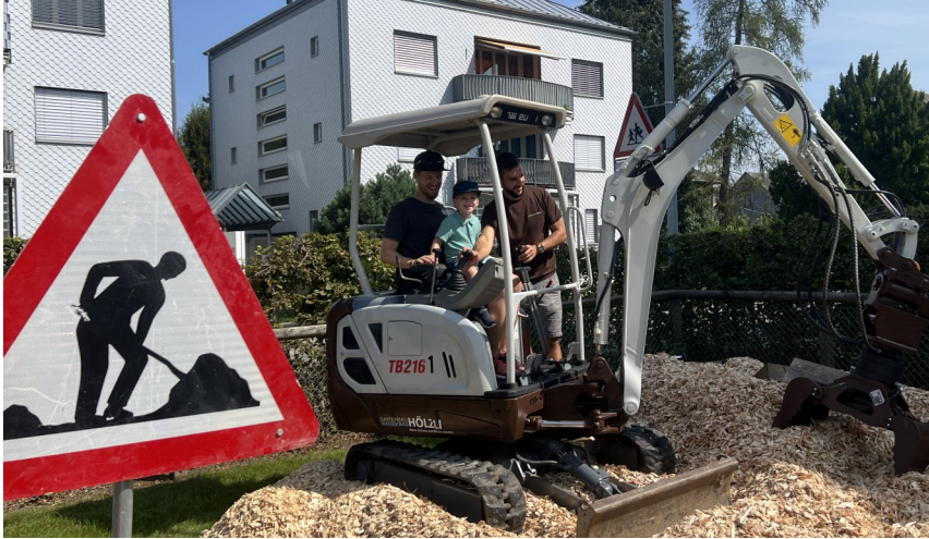
Tatkräftige Unterstützung bei den Bauarbeiten
